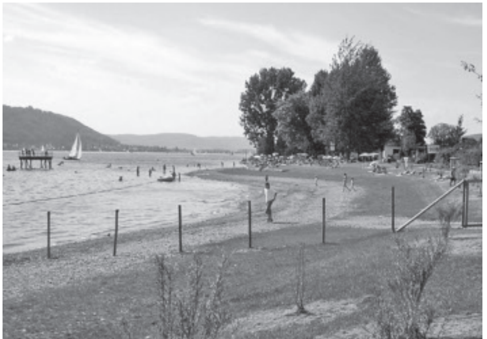
Abb. 5+6: Strandbad-Sanierung am westlichen Bodensee-Obersee als Renaturierungsmassnahme (Baden-Württemberg, Gemeinde Sipplingen); Abb. 5: während der Baumassnahmen im Februar, 2007 Abb 6: nach Fertigstellung im August 2007. (Fotos: W. Ostendorp) Fig. 5+6 : Assainissement de la plage du lac de Constance-Obersee ouest en tant que mesure de renaturation (Baden-Wurtemberg, commune de Sipplingen); Fig. 5 : pendant les travaux en février 2007, Fig. 6: après l'achèvement en août 2007. (photos : W. Ostendorp)
