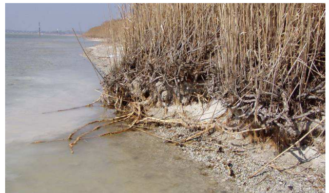
Abbildung 1: Erosionsschäden an Insel Langenrain (Wollmatinger Ried), 30.03.2004.
